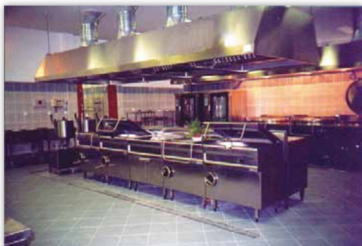
Port Wojenny w Gdyni , obiekt zrealizowany wspólnie z firmą GAMA z Koszalina
